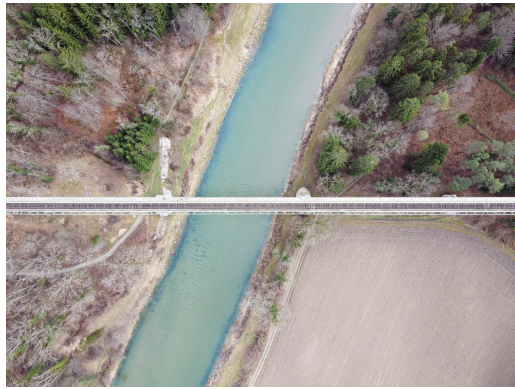
Die Sperrung der Thurbrücke Ossingen gab den Ausschlag. Bild: Wikipedia.org
