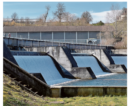
Rheinau ist ein Ausleitkraftwerk. Das Wasser wird abgezweigt, zu einer Turbine und anschliessend zurück ins Fließgewässer geführt. Der Flussabschnitt zwischen Entnahme und Rückgabe wird als Restwasserstrecke bezeichnet. Bild: Archiv
