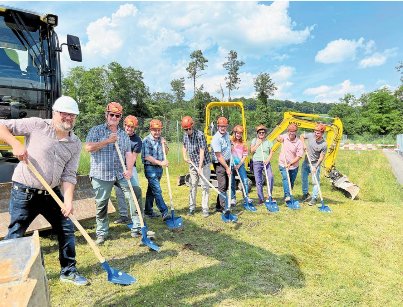
Für Präsident Erich Wipf (6.v.l.) ein denkwürdiger Anlass: Spatenstich für den Zusammenschluss seiner Gruppenwasserversorgung Kohlfirst mit Thurtal-Andelfingen. Unter anderen dabei: Ingenieur Roland Brandenberger (l.), die Betriebsleiter Geru Bichsel (GWVTA, 2.v.l.) und Jakob Strasser (4.v.l.) sowie der Andelfinger Gemeinderat Peter Müller (5.v.l.). Bild: spa
