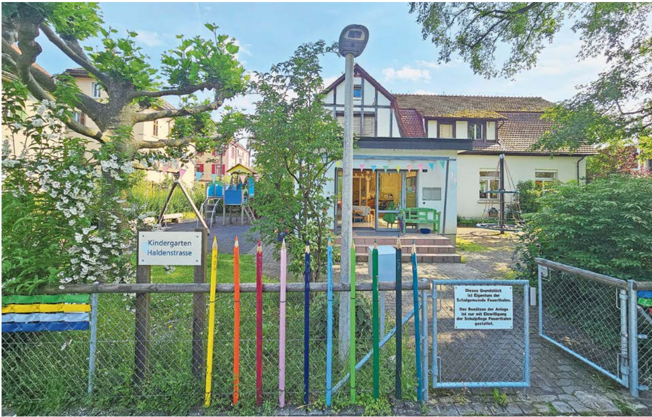
Der Kindergarten an der Haldenstrasse braucht eine Sanierung. Das Gebäude besteht seit 1908 und ist denkmalgeschützt. Bild: jbe
